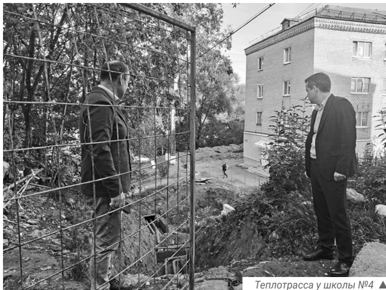
Теплотрасса у школы №4 ▲
