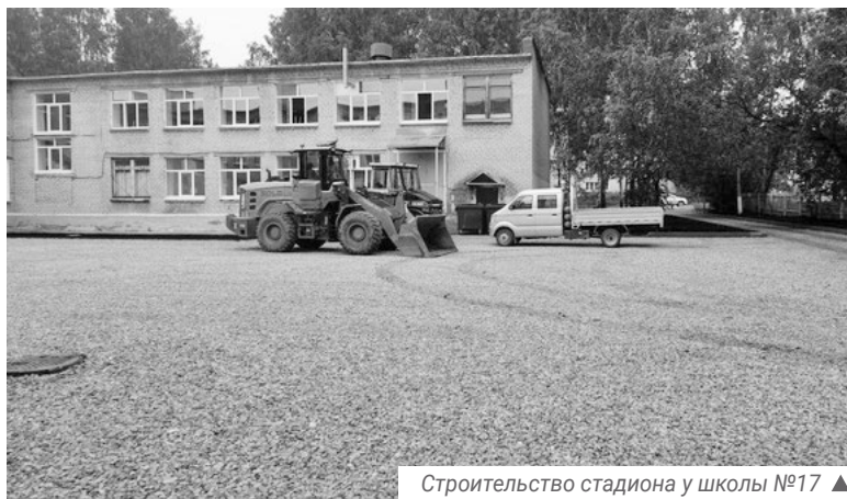
Строительство стадиона у школы №17 ▲
