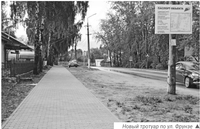
Новый тротуар по ул. Фрунзе ▲
