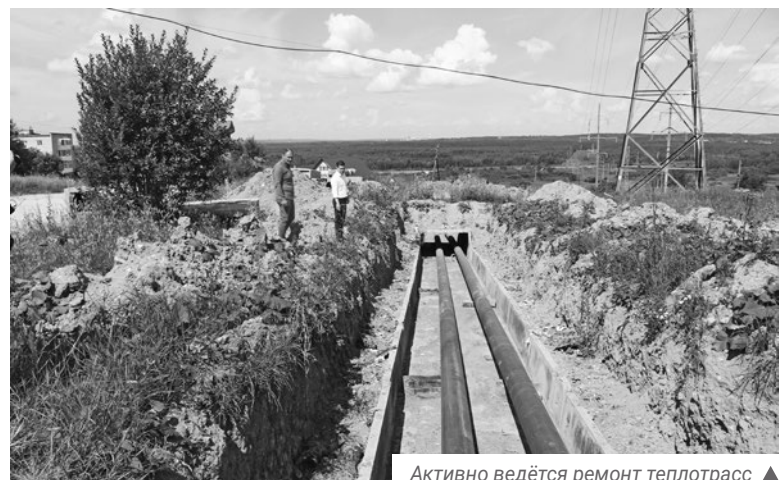
Активно ведётся ремонт теплотрасс ▲
