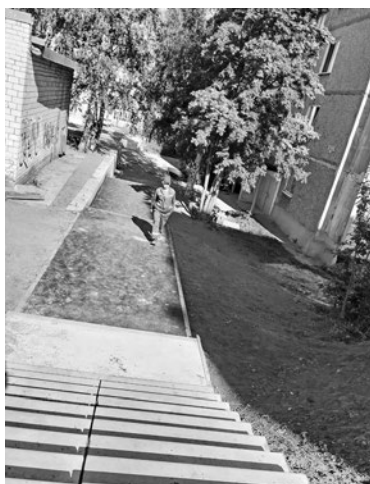
Ремонт двора по ул. П. Коммуны, 20 ▲
