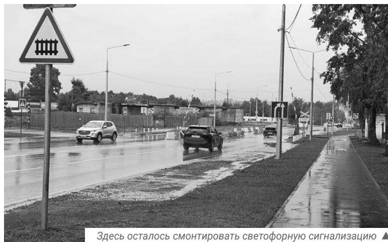
Здесь осталось смонтировать светофорную сигнализацию ▲
