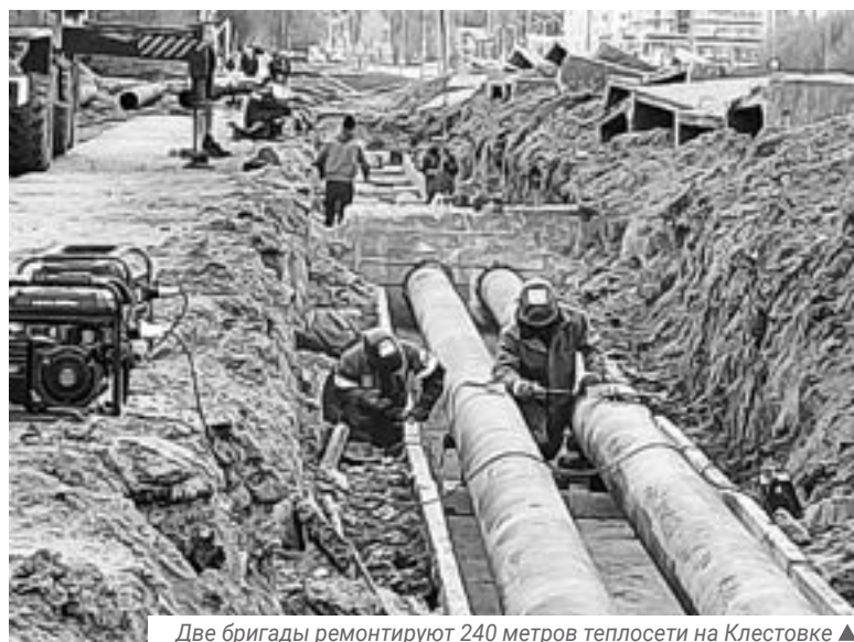
Две бригады ремонтируют 240 метров теплосети на Клестовке ▲
