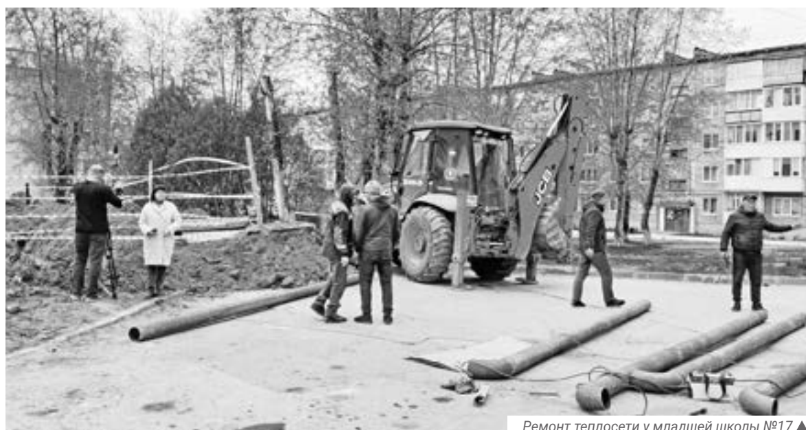
Ремонт теплосети у младшей школы №17 ▲
