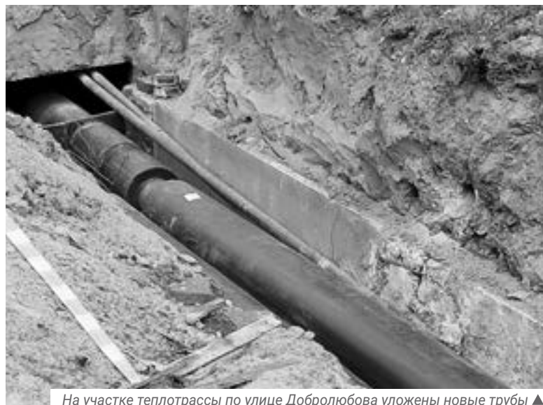
На участке теплотрассы по улице Добролюбова уложены новые трубы ▲
