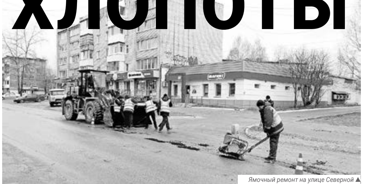
Ямочный ремонт на улице Северной ▲
