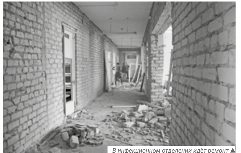
В инфекционном отделении идёт ремонт ▲
