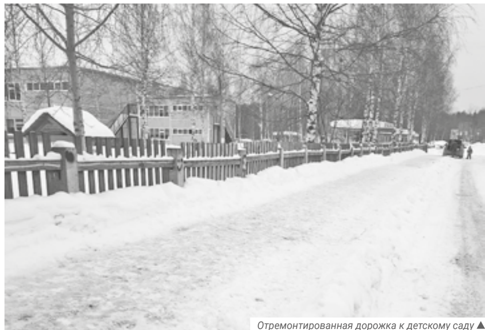
Отремонтированная дорожка к детскому саду ▲
