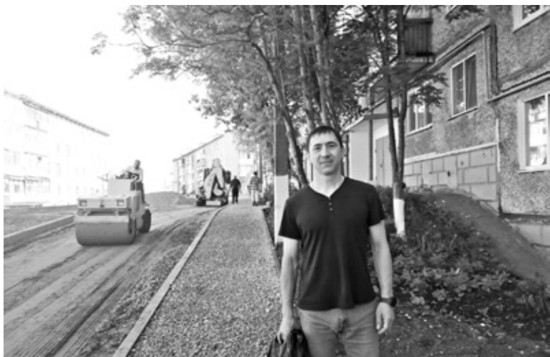
Во время ремонта придомовой территории по ул. Привокзальной, 12 «а» ▲
