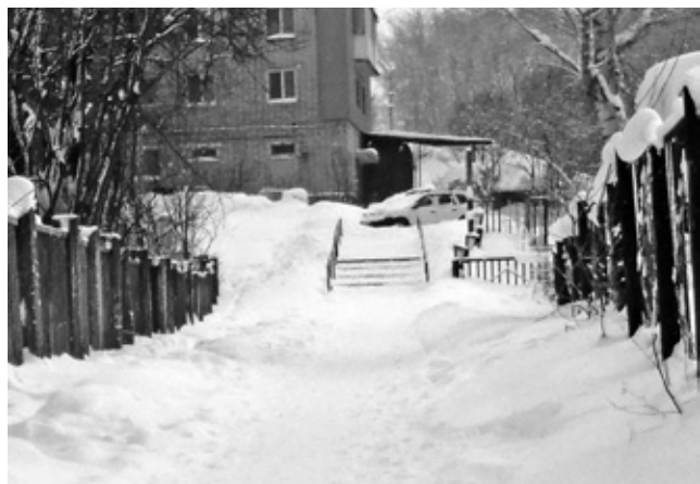
Новая дорожка между детским садом и школой ▲
