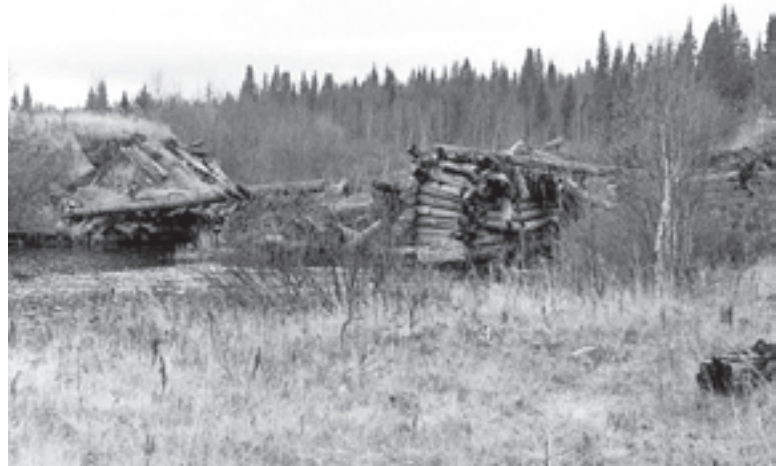
Бывший мост на Бабиновской дороге
