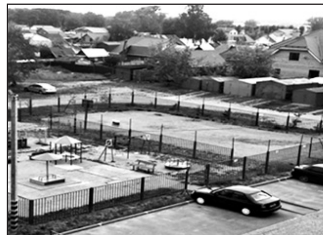
Проект «Устройство основания спортивной площадки», ТОС «Дубрава», ул. Дубравная, 51 ▲
