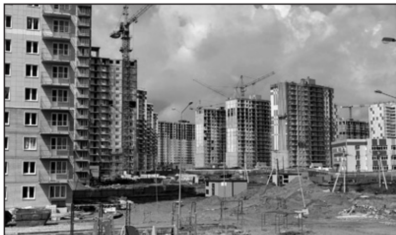
Строительство микрорайона "Любимов" ▲
