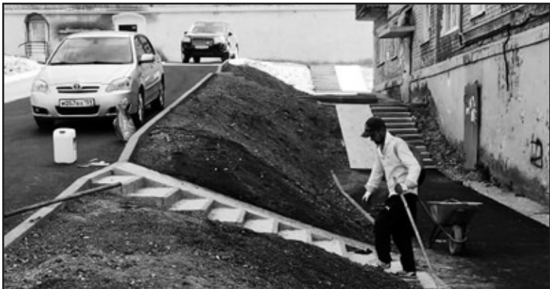
Ремонт двора по ул. 20-летия Победы, 154 ▲
