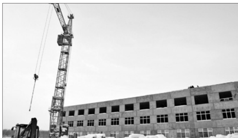
Ведётся строительство школы на Клевовке ▲
