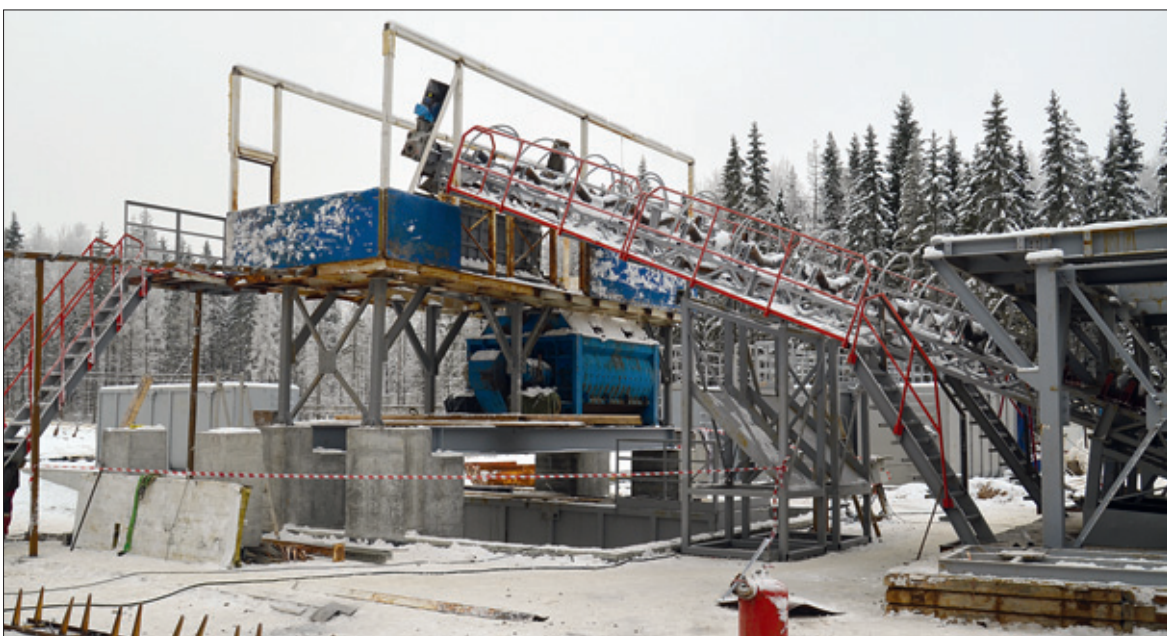
Монтаж мини-завода по производству глинистых смесей ▲
