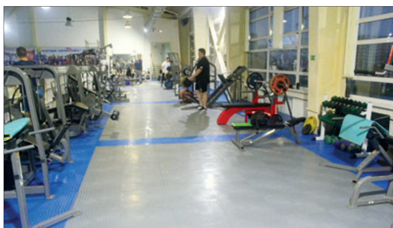
Вибропоглощающее покрытие пола в тренажёрном зале ▲
