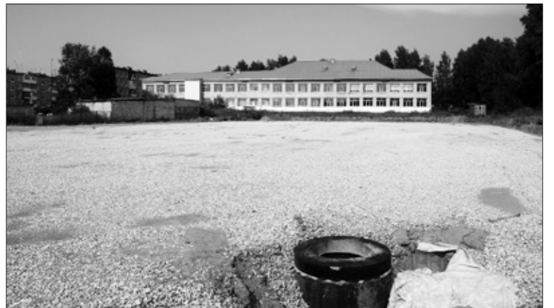
Дренажная система на межшкольном стадионе ▲
