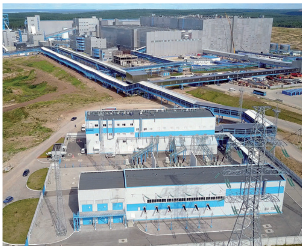
Понижительная подстанция 220 кВ "КамаКалий" на промплощадке комбината
