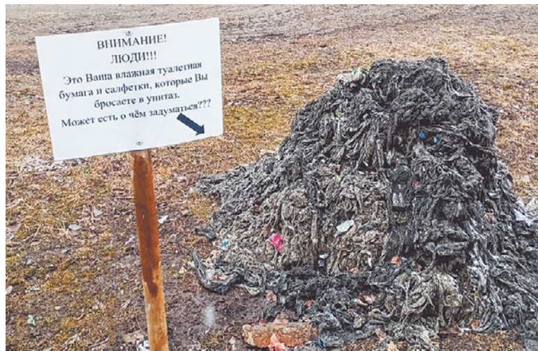
Извлеченный мусор в районе малосемейки на Клевовке. Как говорят специалисты, в данном случае они прочистили всего около 30 метров канализационной трубы и извлекли оттуда столько мусора – салфетки, ватные палочки. Признаться, скидывали их в унитаз не иначе, как «от души». ▲
