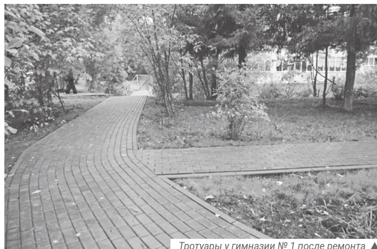
Тротуары у гимназии № 1 после ремонта ▲
