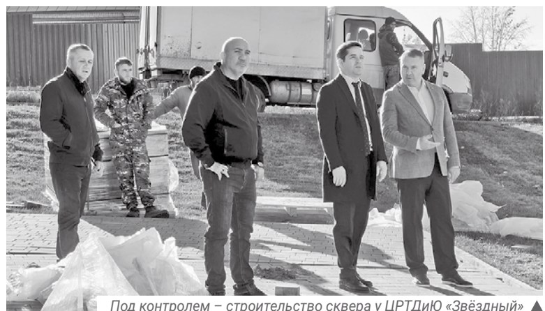
Под контролем – строительство сквера у ЦРТДиУ «Звёздный» ▲
