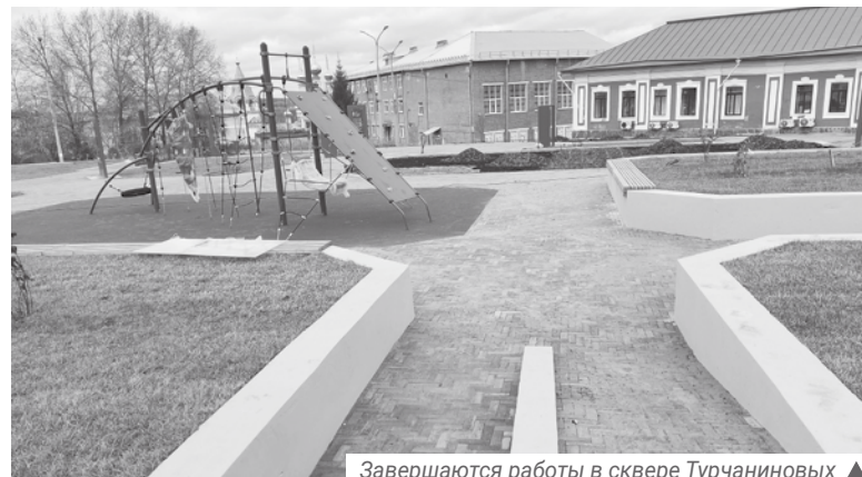
Завершаются работы в сквере Турчаниновых ▲
