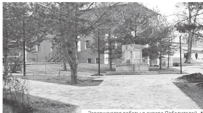
Завершаются работы в сквере Победителей ▲
