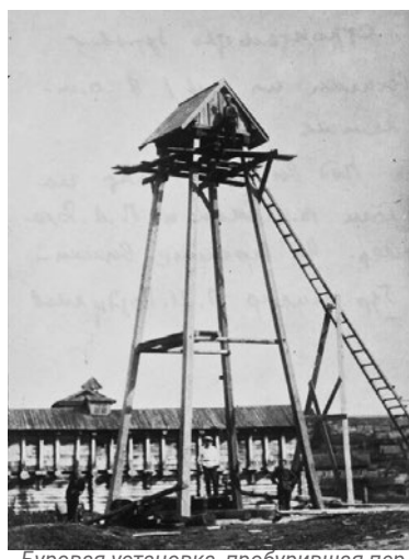
Буровая установка, пробурившая первую скважину, из которой был поднят первый сильвинит. 1925 год ▲
