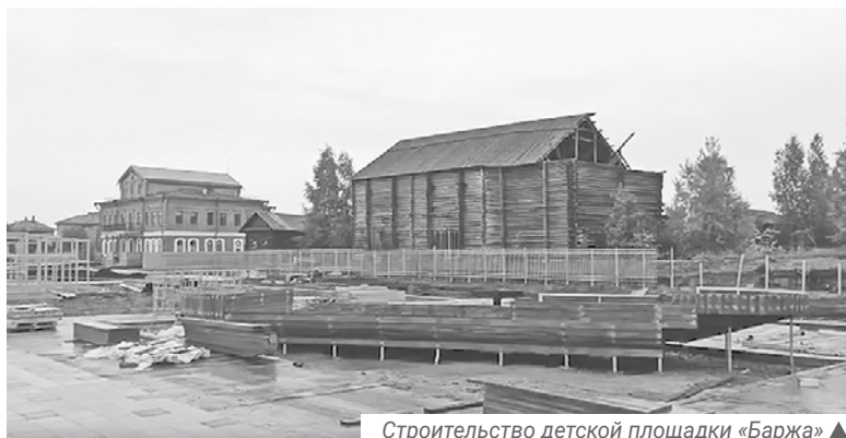
Строительство детской площадки «Баржа» ▲
