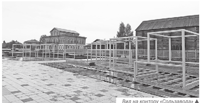
Вид на контуры «Сользавода» ▲
