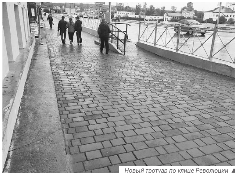
Новый тротуар по улице Революции ▲
