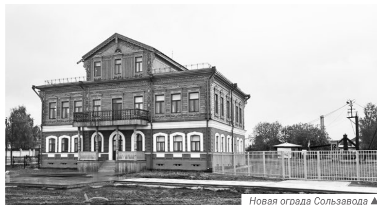
Новая ограда Сользавода ▲
