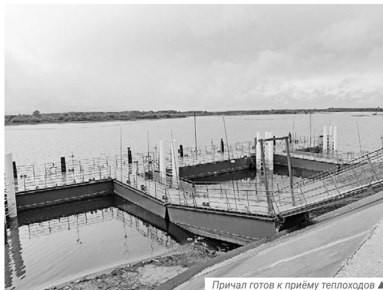
Причал готов к приёму теплоходов ▲
