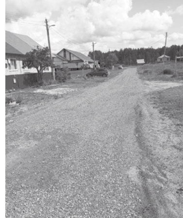
Ремонт участков дорог в Усовском ▲
