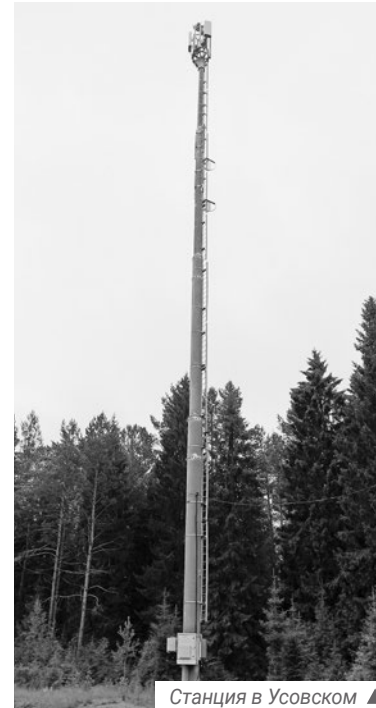
Станция в Усовском ▲
