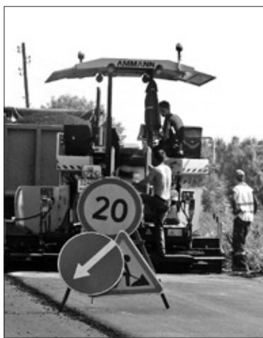
Ремонт дороги в с. Родники
