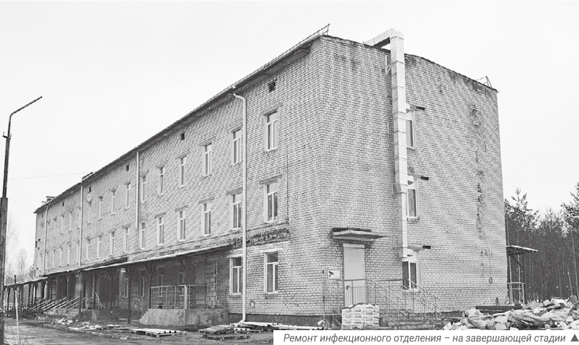
Ремонт инфекционного отделения – на завершающей стадии ▲
