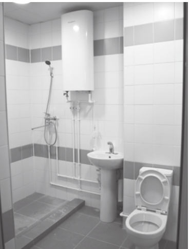
Санузел инфекционного отделения ▲
