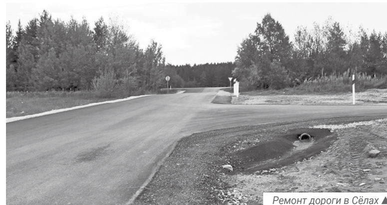
Ремонт дороги в Сёлах ▲
