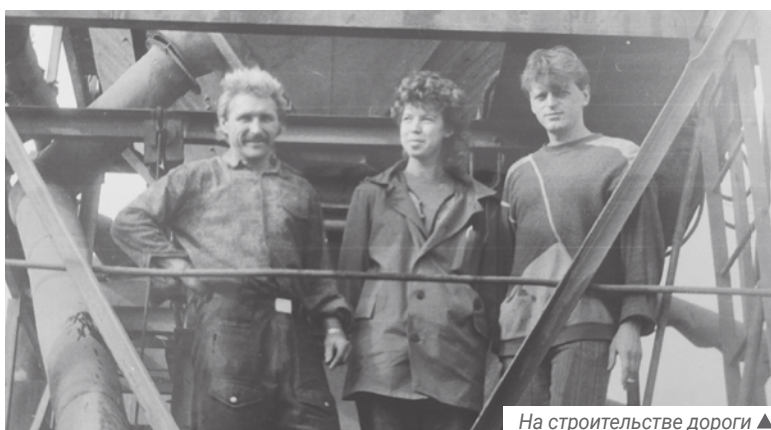
На строительстве дороги ▲
