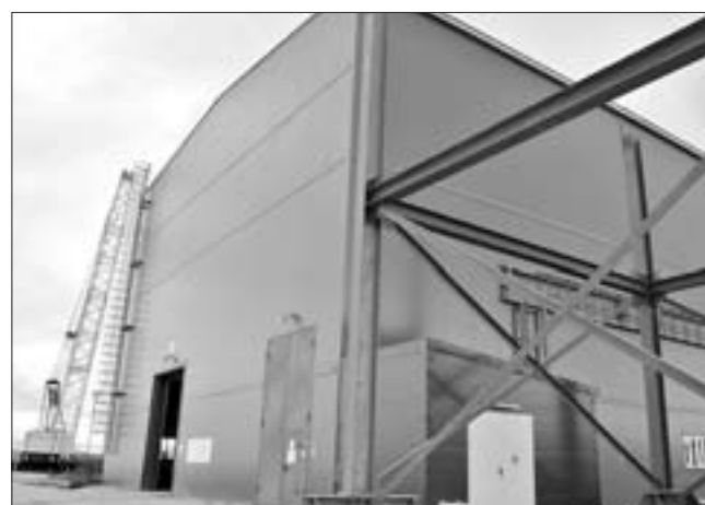
Временное надшахтное здание ствола №1
