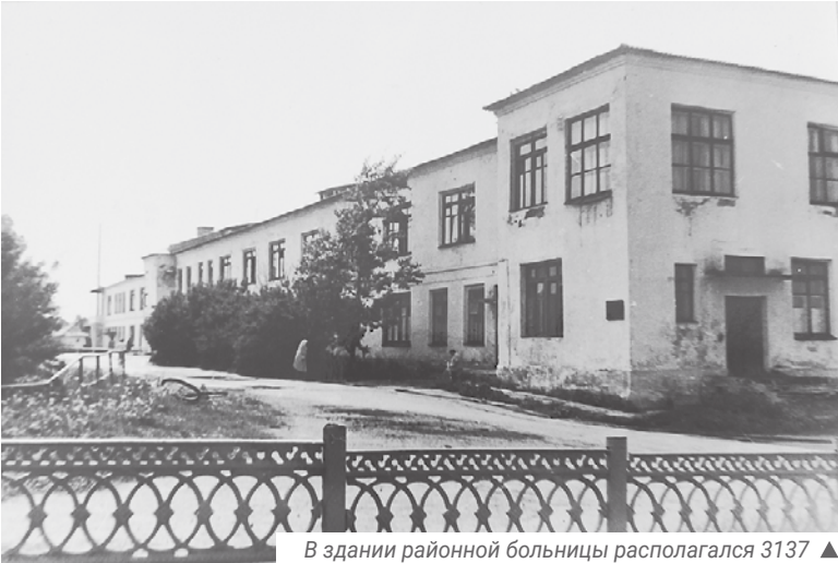
В здании районной больницы располагался 3137 ▲
