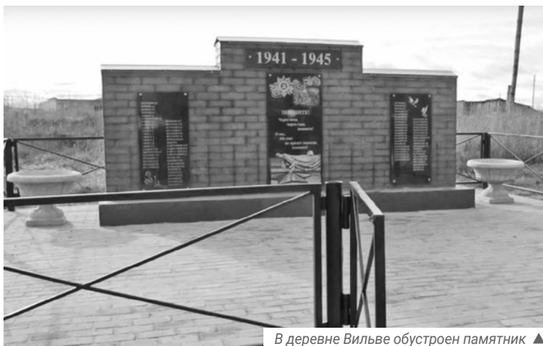
В деревне Вильве обустроен памятник ▲
